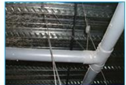
Condensate pipes
